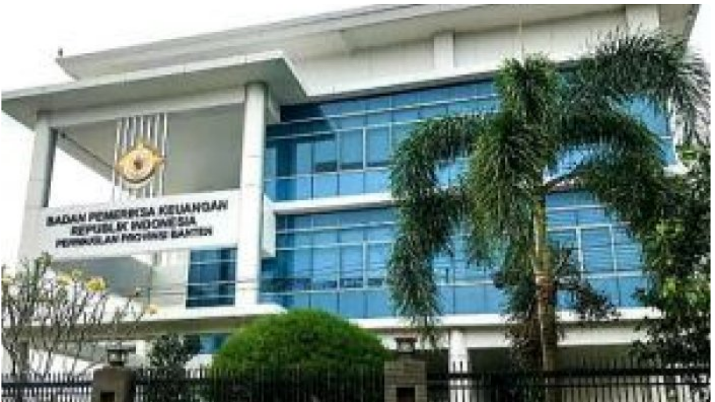
Gedung BPK RI Perwakilan Banten di Palima Kota Serang
